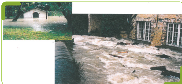
Inondations de 2001 dans Rennemoulin
