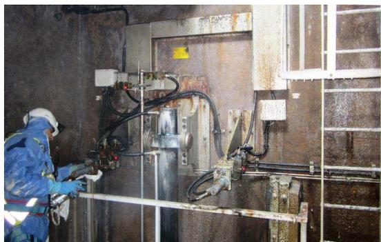
*Opération de graissage des vérins de verrouillage sur le PT5*
