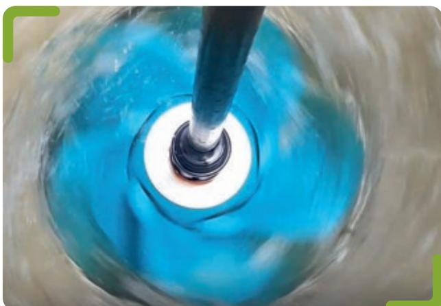
Une micro-turbine hydroélectrique a été installée dans l'ouvrage génie civil existant, situé en bordure du ru de Gally, avant rejet de l'eau traitée au milieu naturel.
