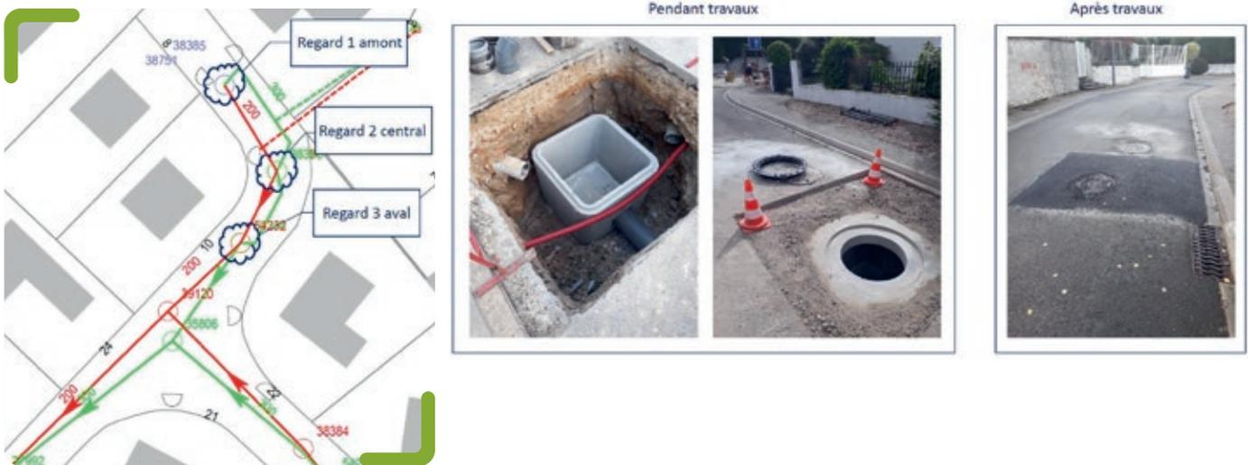
> La suppression de 2 raccordements d'Eaux Usées vers le réseau d'Eaux Pluviales allée des Castors et rue Jean Mermoz à Fontenay-le-Fleury permettant ainsi de supprimer la pollution équivalente à 110 personnes dans le milieu naturel pour un montant de 143 k€.
