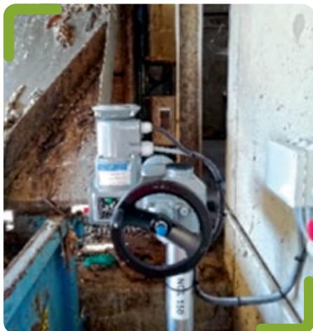
Une vanne permettant d'isoler les Postes de Relèvement « réseaux séparatifs » / « réseaux unitaires » a été mise en place en mai 2020 permettant de réduire de manière significative les by-pass vers le milieu naturel et la consommation énergétique de la STEP.
