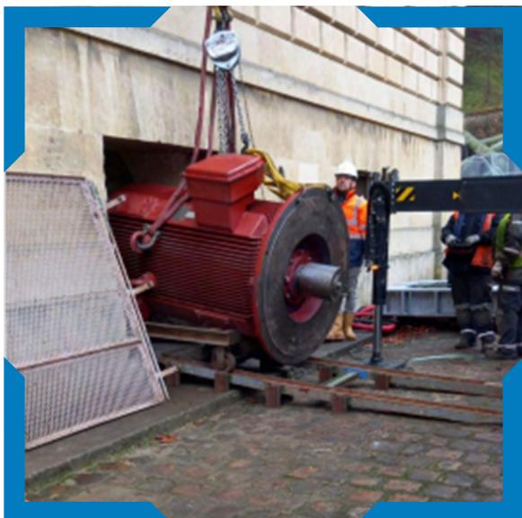
Les travaux de mise hors-crue, de renouvellement des pompes et de l'hydraulique de la station de pompage de Bougival ont débuté à mi-année 2022, après une phase préparatoire de plusieurs mois. Les répercussions de la crise du covid ont impacté significativement des délais de fourniture du matériel et leur transport depuis l'Asie. Si bien que les corps des pompes ont dû être affrétés par avion. Finalement les travaux ont pu commencer après réception des pompes.
