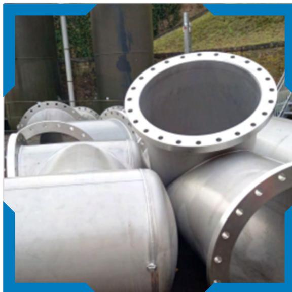
Le chantier a débuté par la modification du Génie-Civil pour permettre la réhausse des moteurs, puis par la réalisation des pièces de chaudronnerie. La complexité de la réalisation réside dans la continuité de service de la station, si bien que les transformations affectent les pompes à tour de rôle. Un groupe de pompage minimal doit alimenter l'usine, mais ne bénéficie d'aucun matériel de secours. AQUAVESC a profité de ces travaux pour engager la révision périodique des moteurs.
