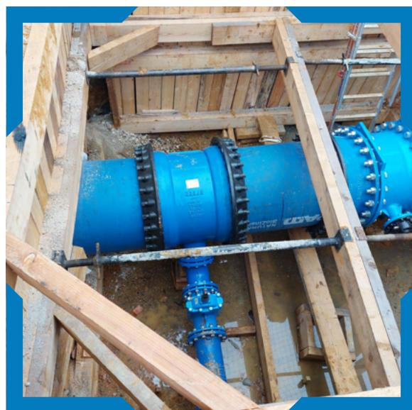
L'impact des dernières casses de la conduite en DN 600 mm a montré que le renouvellement de cette liaison était indispensable : ces conduites seront remplacées par une unique conduite de diamètre 800 mm sur un linéaire de 4 kilomètres, ce qui permettra d'alimenter dans un premier temps les réservoirs des Hubies, et à terme de renforcer les transferts vers le sud du territoire grâce à la Liaison Nord-Sud.
