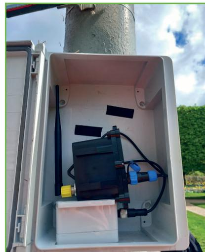
Mise en place de la trappe anti-odeur par les équipes de SEVESC sur PT<sub>5</sub> et capteur  $H_2S$
